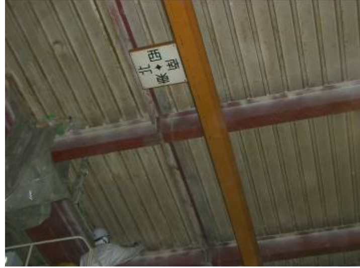
<ふうじろう 撤去状況>
