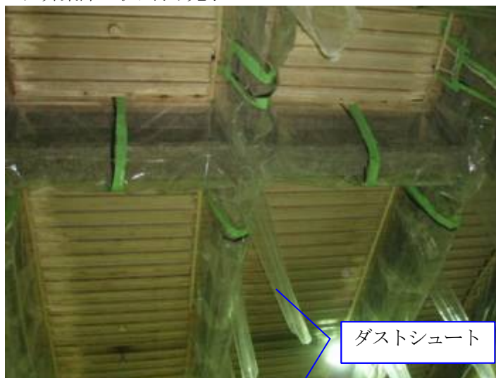
<天井梁部 取り付け完了>
