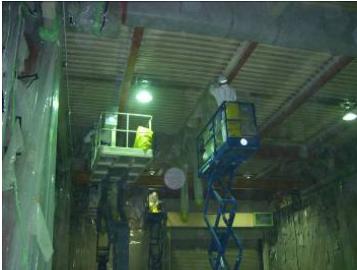
<ふうじろう 撤去状況>
