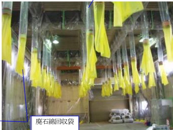
<全体 取り付け完成>
