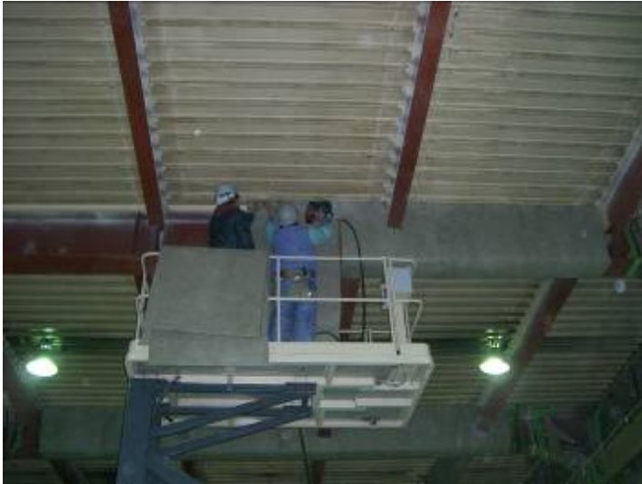
<耐火復旧 除去と平行作業>
