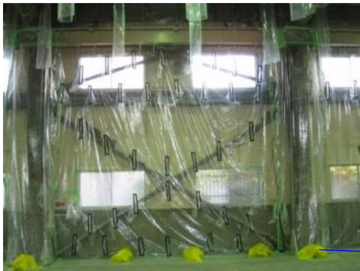
<壁側 取り付け完成>
