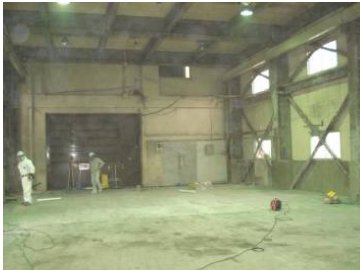
<作業前 現場状況>
