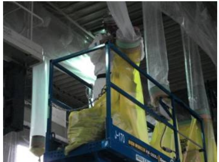
<廃石綿の廃棄袋への回収>
